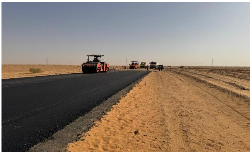
يوضح الشكل (4) عملية دمك الطبقة الاسفلتية.
