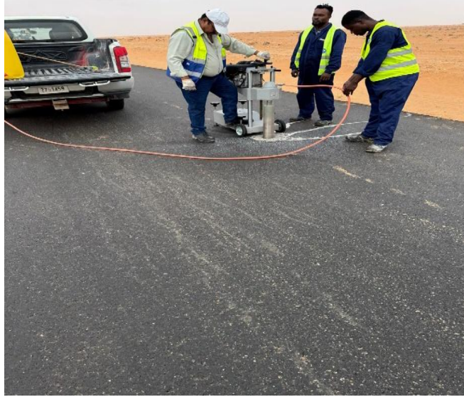
يوضح الشكل (1) عملية استخراج عينة الكور.
