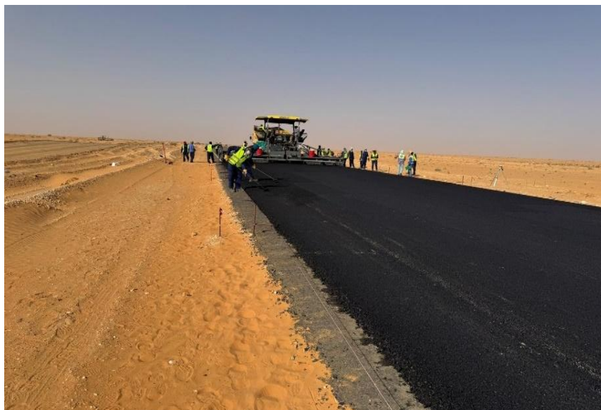
يوضح الشكل (3) فرش الطبقة الاسفلتية
